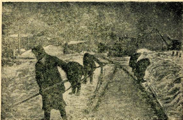
Железнодорожники Тихвинского узла расчищают и восстанавливают пути и станционные сооружения, разрушенные немецко-фашистскими оккупантами.
